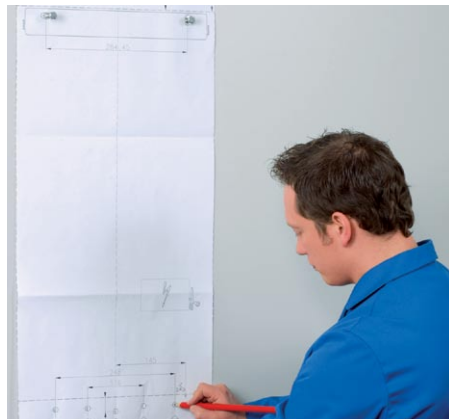
1. Wyprowadzenie przyłączy przy użyciu szablonu
