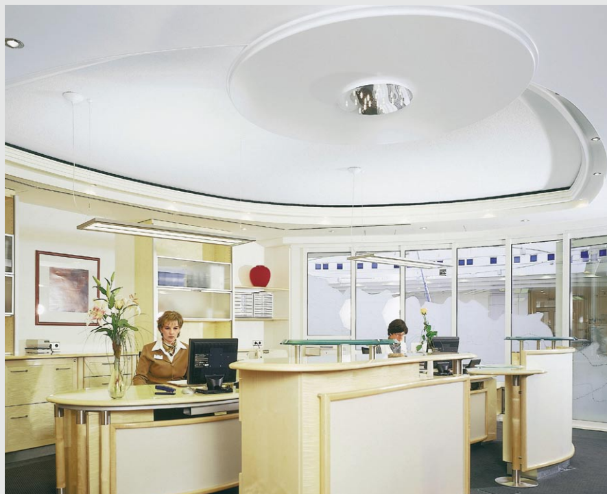
Rys. 8. System stropów chłodzących (foto: Firma EMCO)
