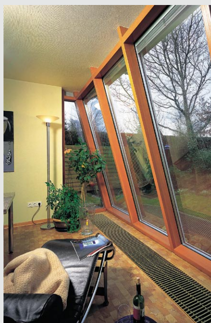
Rys. 9. Konwektory podłogowe z wentylatorem (foto: Firma EMCO)
