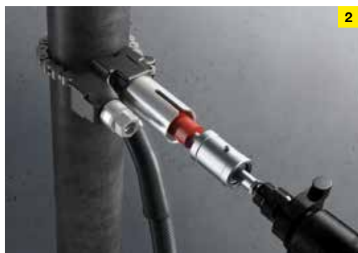
2. Wykonanie otworu wiertarką i ściągnięcie uchwytu do prowadzenia wrzeciona wiertarskiego.
