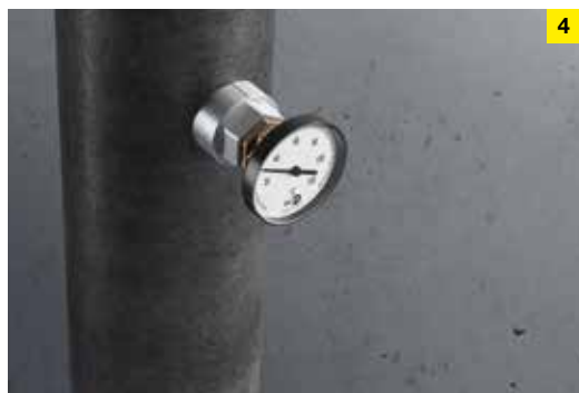
4. Idealne przyłącze w rurze stalowej do podłączenia termometru, czujnika temperatury, manometru, zaworu spustowego lub przewodu jest już gotowe.
